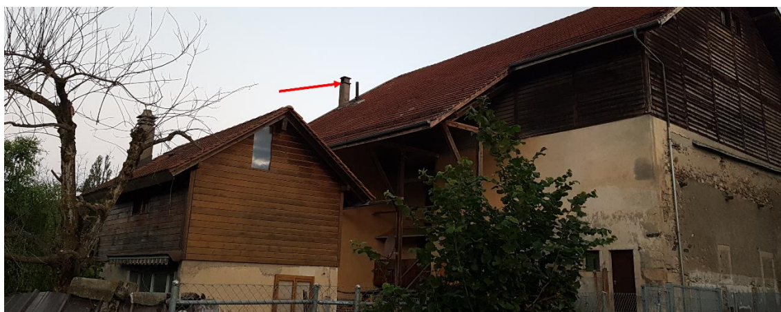
Figure 6. Point d'entrée/sortie des chauves-souris identifiés sur le bâtiment sis au Chemin du Moulin 2 (ID n°38).
